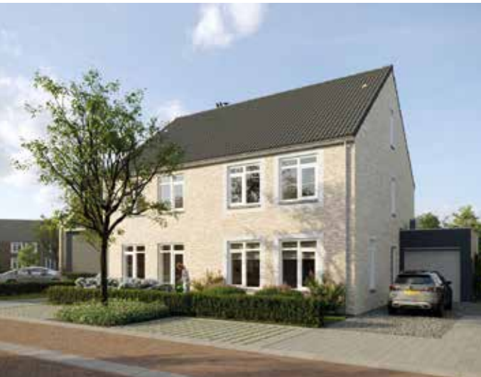
Twee-onder-één-kapwoningen Bouwnummers: 19 & 20 en 55 & 56
